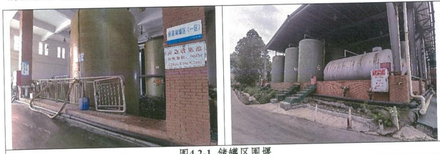
图4.2-1 储罐区围堰
