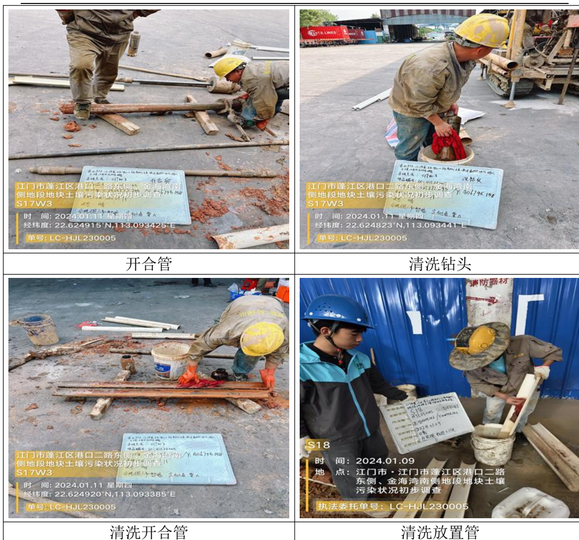
图4.4-1初步调查土壤钻孔现场工作照片
