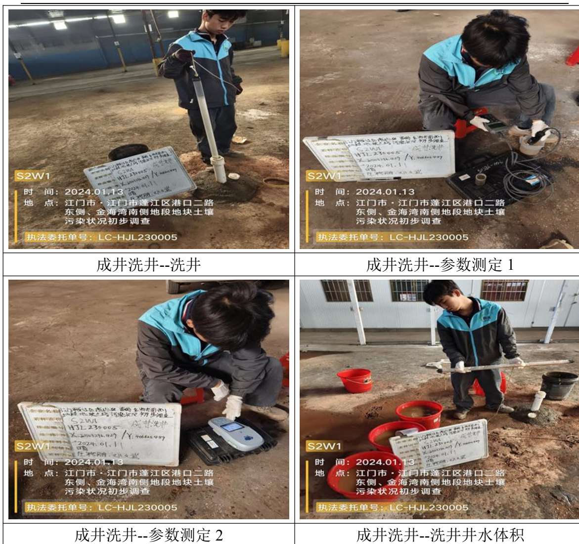
图4.4-2初步调查地下水建井及建井洗井工作照片
