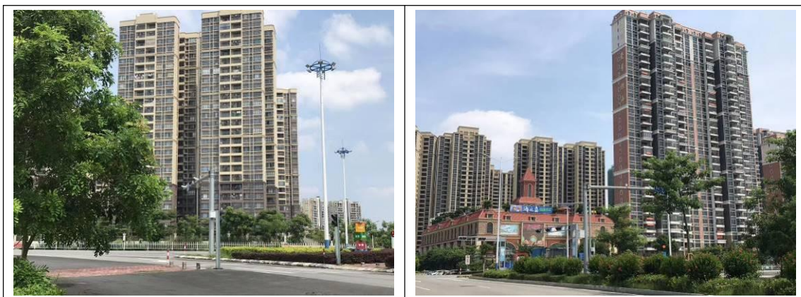
图 3.2-1 现场踏勘照片
