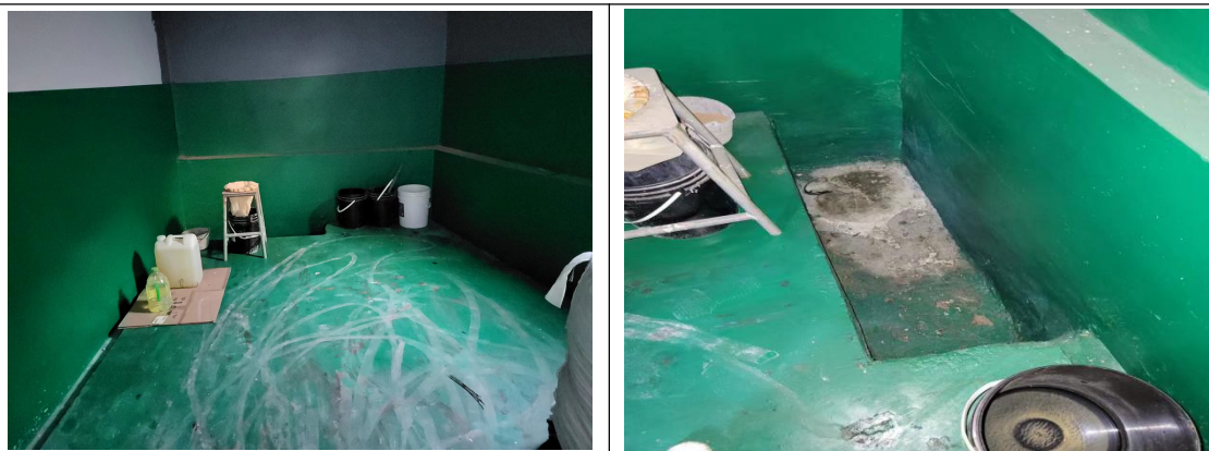
危险废物暂存库
