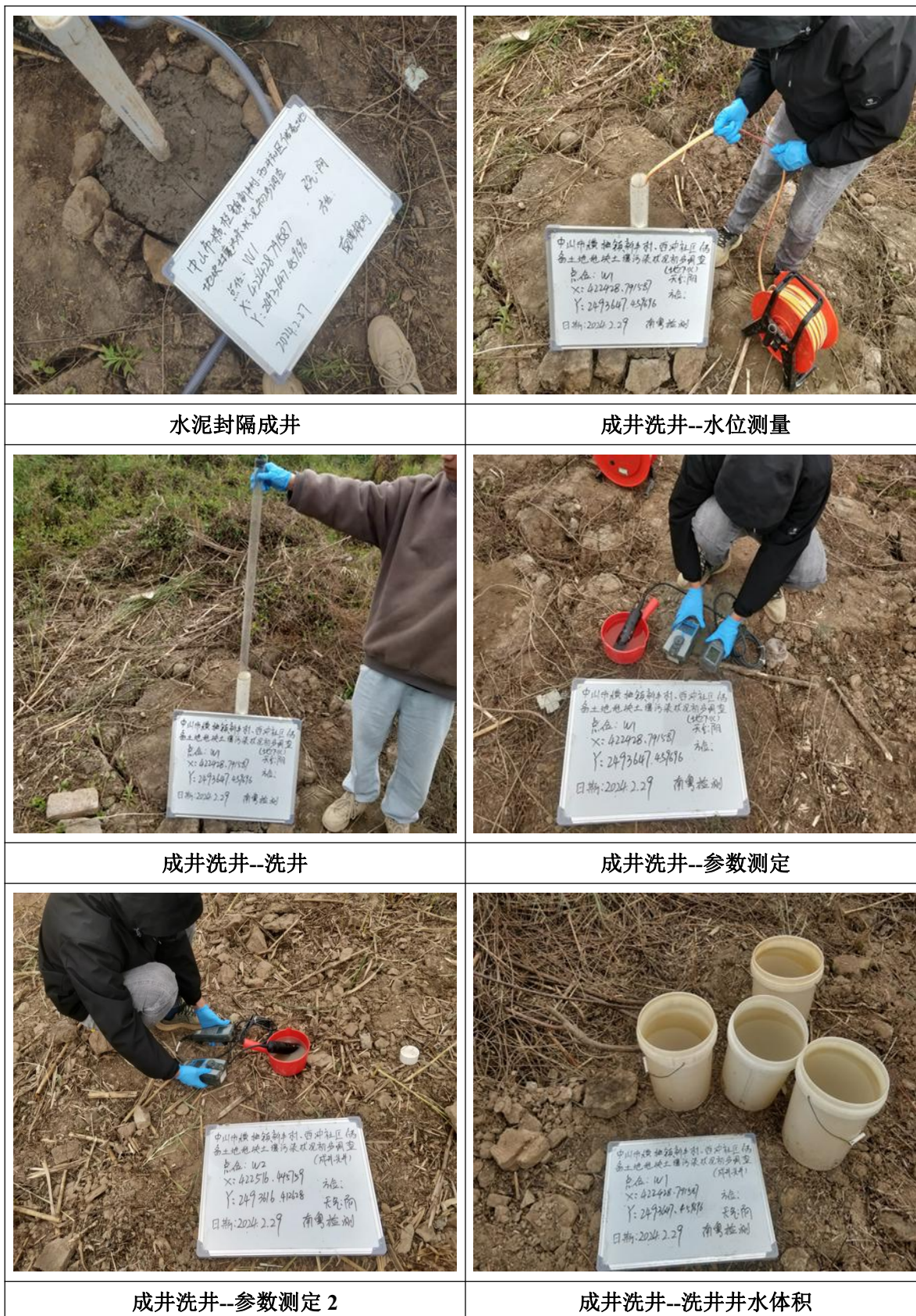
图4.4-2初步调查地下水建井及建井洗井工作照片
