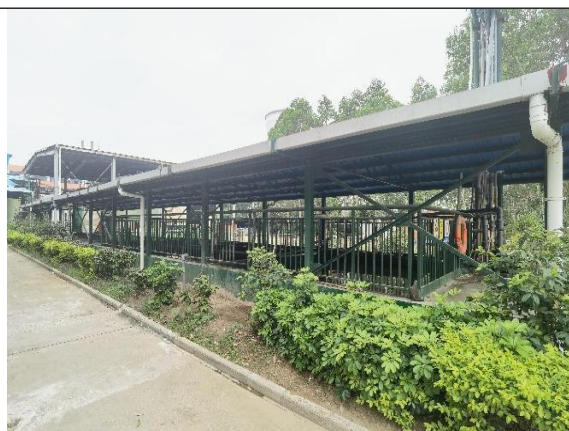
生化废水调节池
