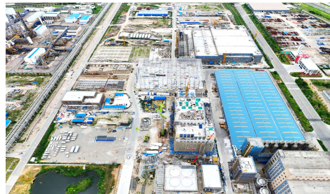
恒新纤维、恒聚新材料、恒诚新材料地块航拍
