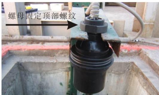
①在探头顶部螺纹用螺母固定
