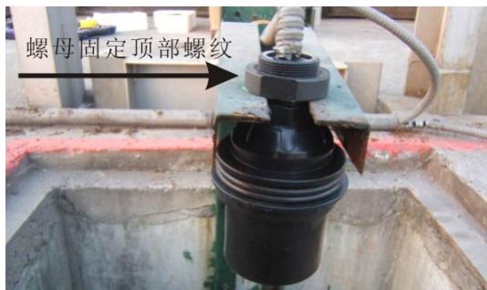
①在探头顶部螺纹用螺母固定
