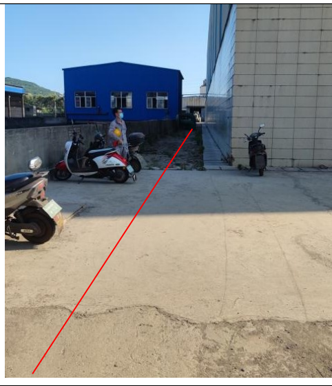
大东海厂区，埋地敷设
