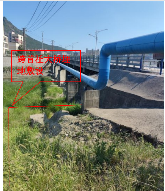
跨首祉大桥处植被恢复
