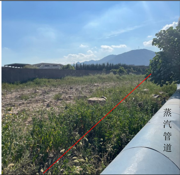
沿疏港路南侧埋地敷设
