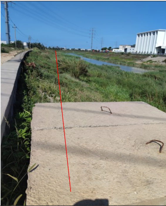
沿首祉溪防洪堤埋地敷设
