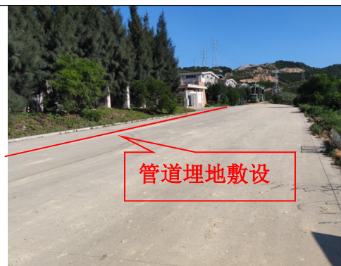
规划御西路道路恢复情况
