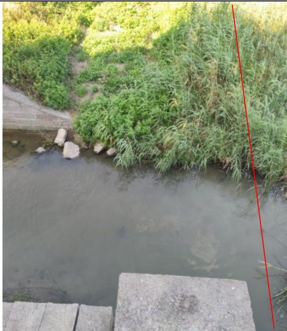
横穿排水渠，埋地敷设
