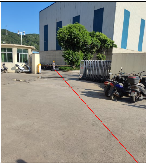
大东海厂区，埋地敷设
