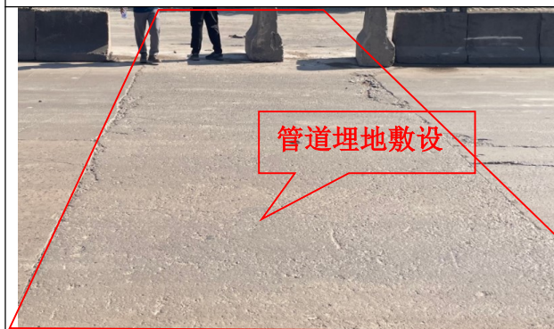
疏港路道路恢复情况
