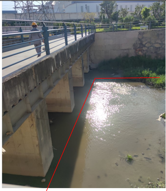
大东海生活区横穿首祉溪部分，埋地敷设
