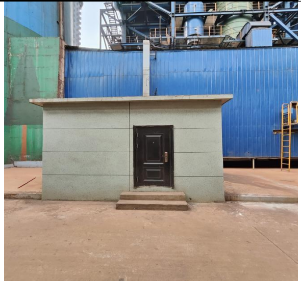
250m 2 烧结机机头烟气在线监控室
