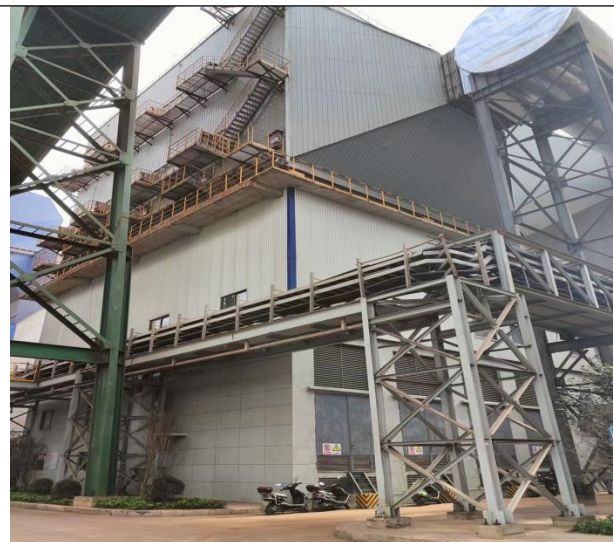
250m 2 烧结机机头烟气除尘
