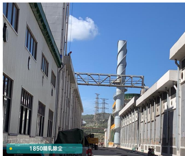
1850热轧精轧排放口、采样平台
