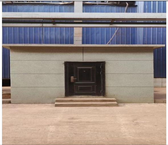
250m 2 烧结机机头烟气脱硫出口在线监测室
