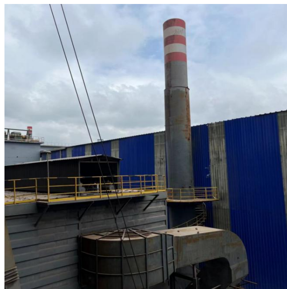
麦尔兹窑原料废气排气筒及采样平台
