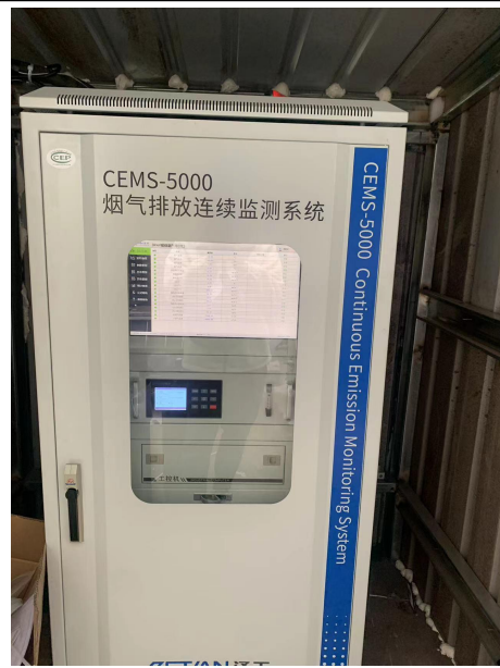
3#-4#石灰窑窑体烟气出口在线监测设施
