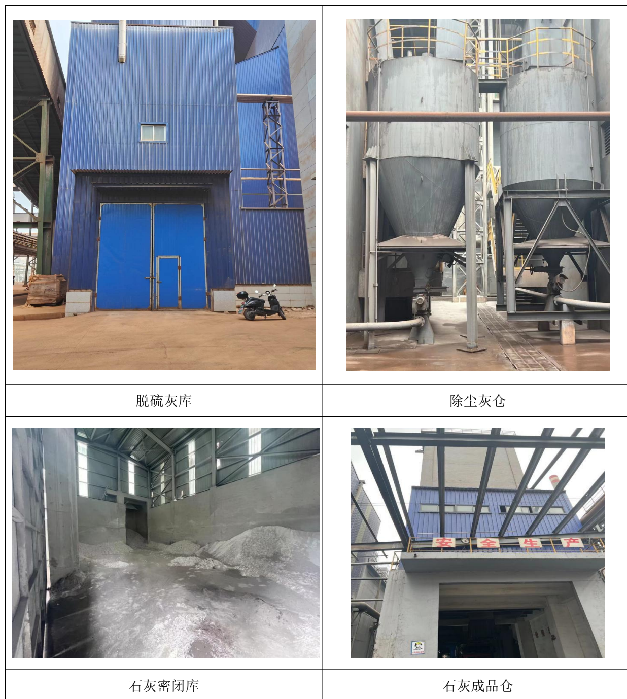
图 4.1-7 固废暂存设施照片
