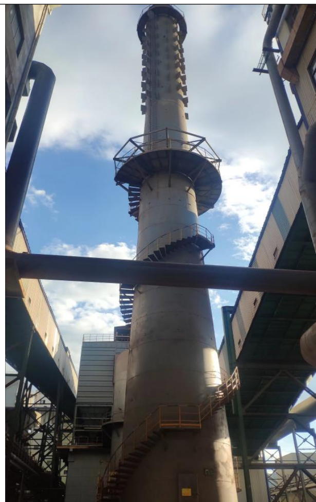
250m²烧结机成品筛分除尘烟囱、采样平台
