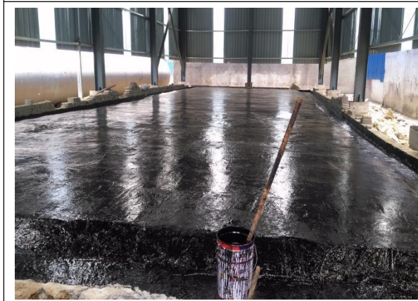
危废暂存间地面防渗
