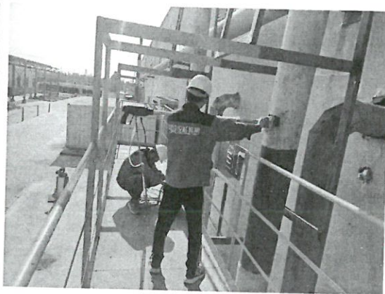
DA008 检测照片
