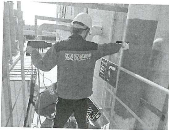
DA005 检测照片
