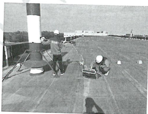
DA001 检测照片
