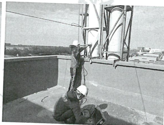
DA011 检测照片
