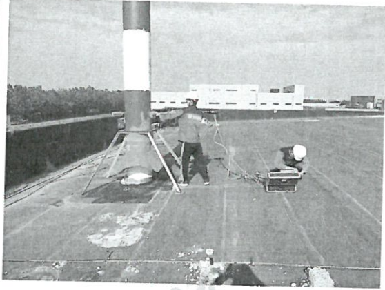
DA004 检测照片
