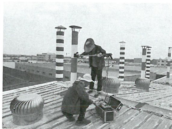
DA017 检测照片
