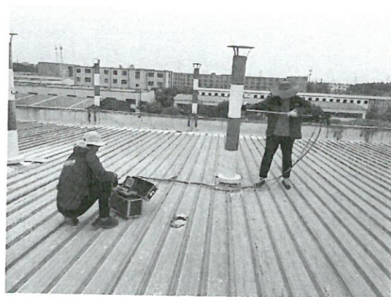
DA025 检测照片
