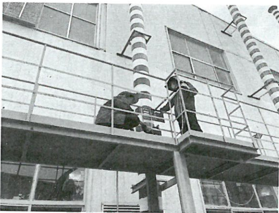
DA003 检测照片
