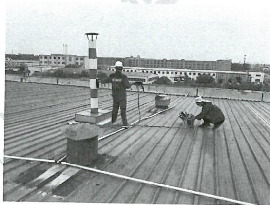
DA027 检测照片
