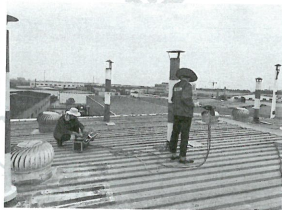
DA021 检测照片
