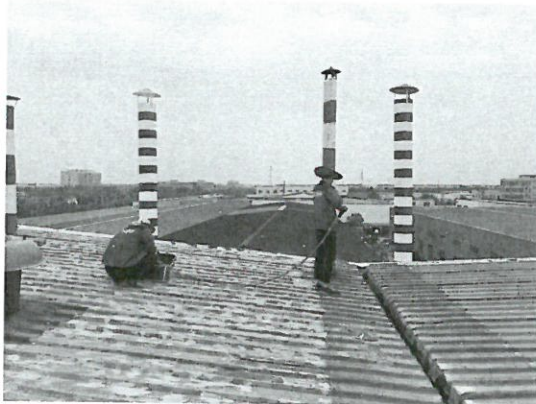
DA014 检测照片
