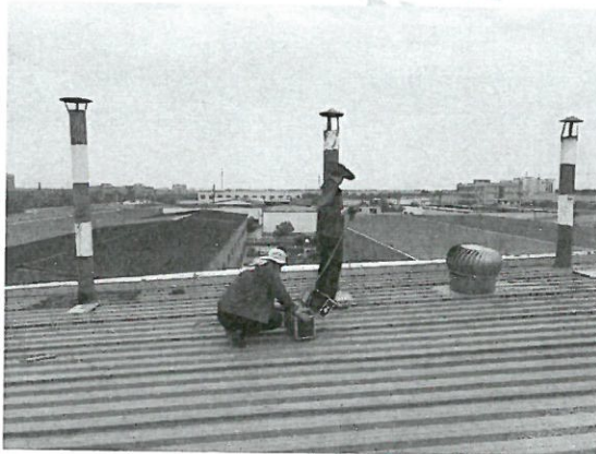
DA022 检测照片
