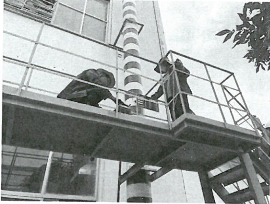
DA005 检测照片
