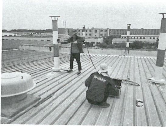
DA024 检测照片
