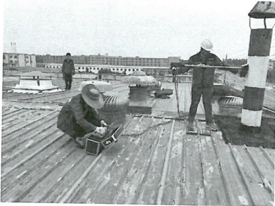
DA026 检测照片
