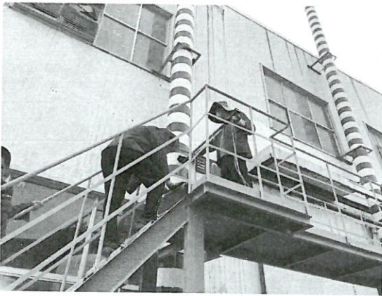
DA001 检测照片
