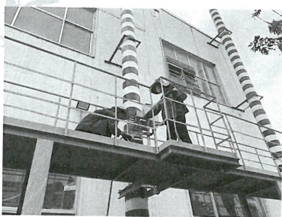
DA004 检测照片
