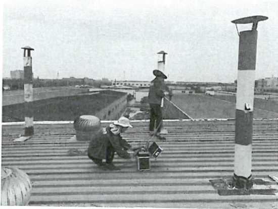
DA020 检测照片
