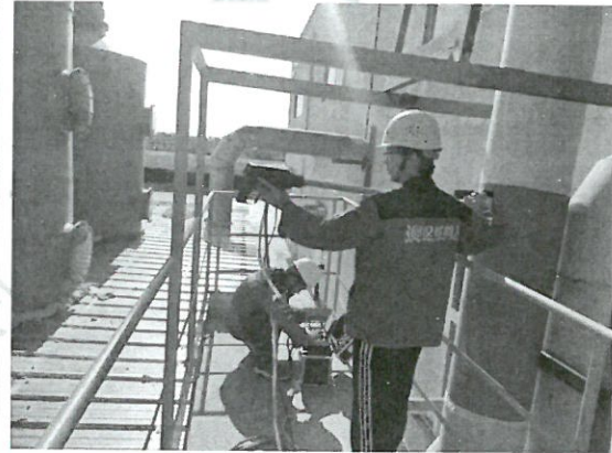
DA006 检测照片
