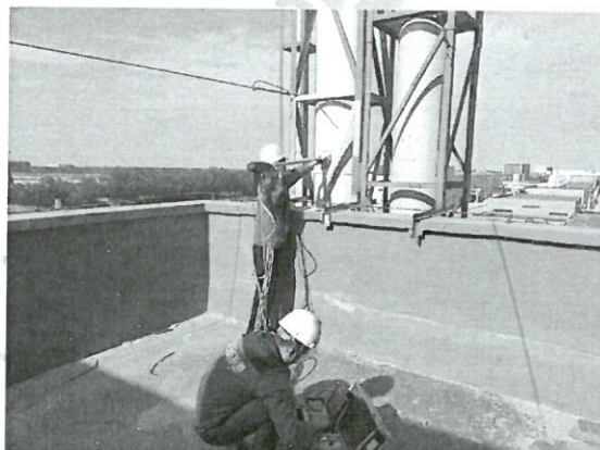
DA011 检测照片
