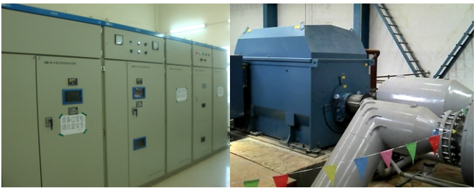
湖北大冶有色制氧压缩机系统 软起动装置型号: ATA QB-H10/17000 电机: ABB 负载: 制氧压缩机 (Siemens) Hubei Daye Nonferrous oxygen compressor system Soft Starter Model:ATA QB-H10/17000 Motor: ABB Load: Oxygen Compressors (Siemens)
