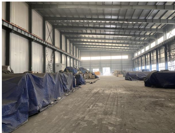
图 1-2 本项目拟建厂址现状照片
