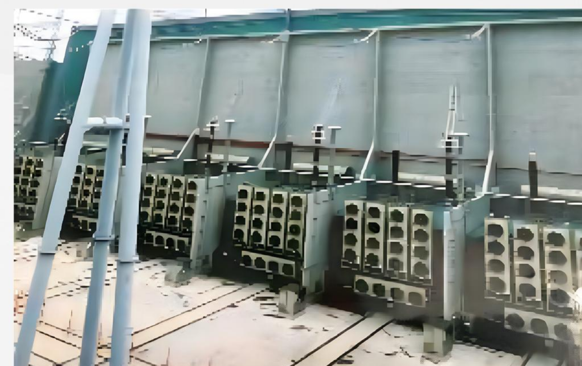
变压器冷却器用于换流变 Transformer cooler for converter
