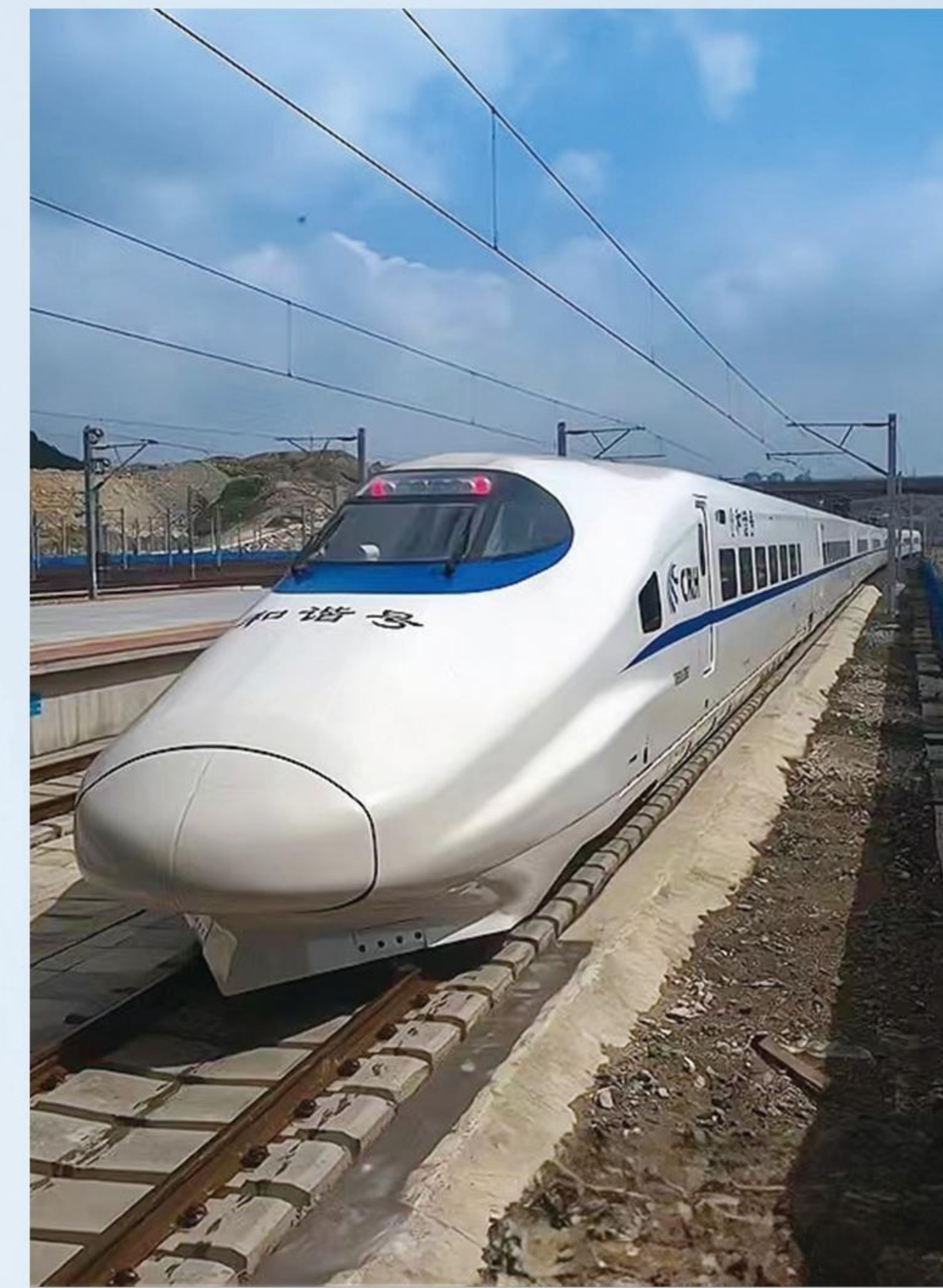
轨道交通 Rail transit
