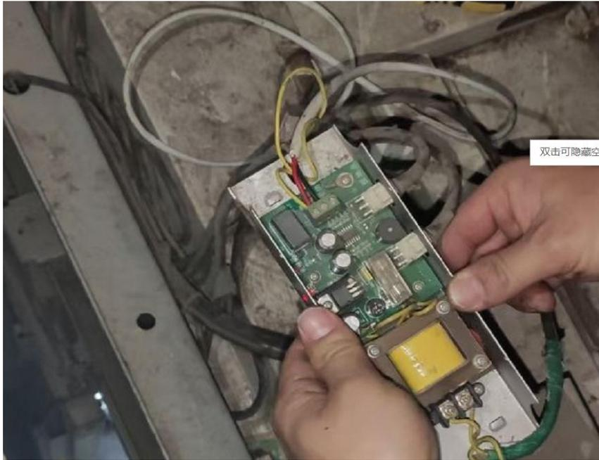
2、电梯品牌西子奥的斯（XIZI OTIS），无光幕控制盒，电梯为常闭信号控制，通过维保人员协助，找到电梯信号控制线，将我司设备常闭信号线串联到电梯信号控制线即可。
