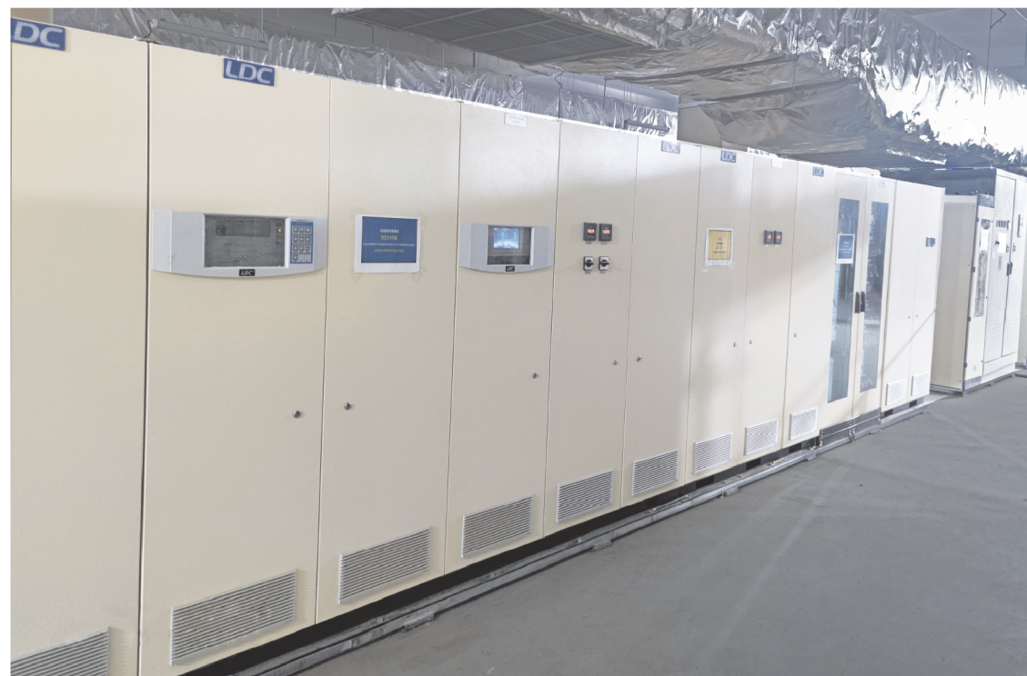
南非红石100MW塔式光热项目——现场图
