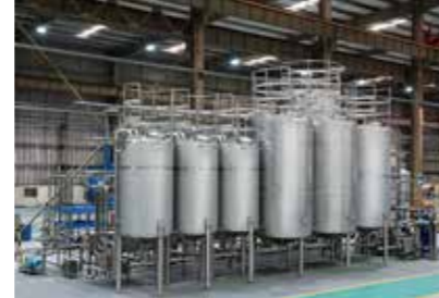
CIP系统出厂前预安装调试
