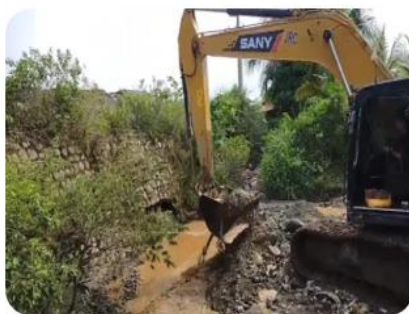
印尼盛拓项目持续为当地村民修缮水渠
