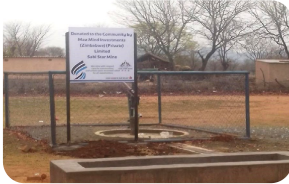
在布赫拉社区 Mhlanga 村建造的带牛槽的水井
