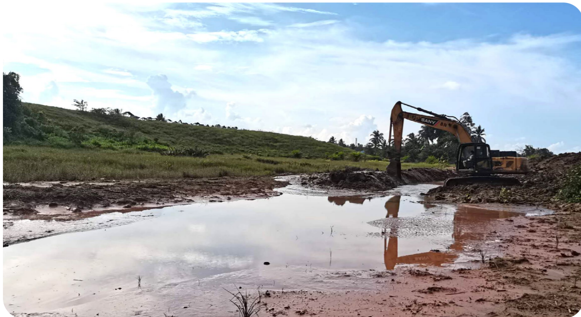
印尼盛拓派遣机械和工具修建排水渠
