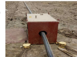
新疆塔河采油一厂HT-PO非开挖O型缩径内衬修复工程
