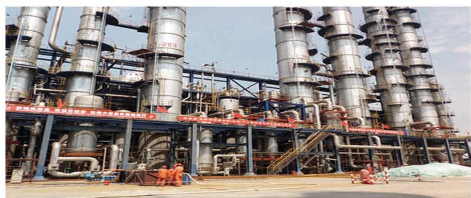
中沙(天津)石化丁二烯装置化学清洗工程
