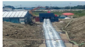
镇海炼化HDPE内衬工程
