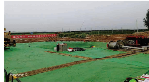
徐州管道局潍坊输油管道封堵项目
