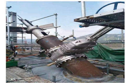
中海壳牌石油化工有限公司 SMOP/POD项目带压45°斜开孔工程
