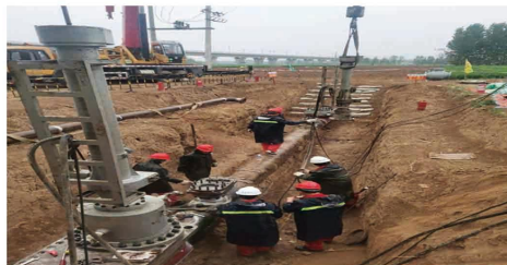
中裕燃气管道不停输带压封堵工程
