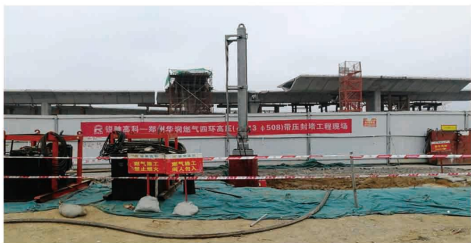
华润Φ813高压燃气管道四封四堵工程
