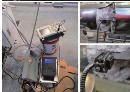
图 7 某研究所安装现场
