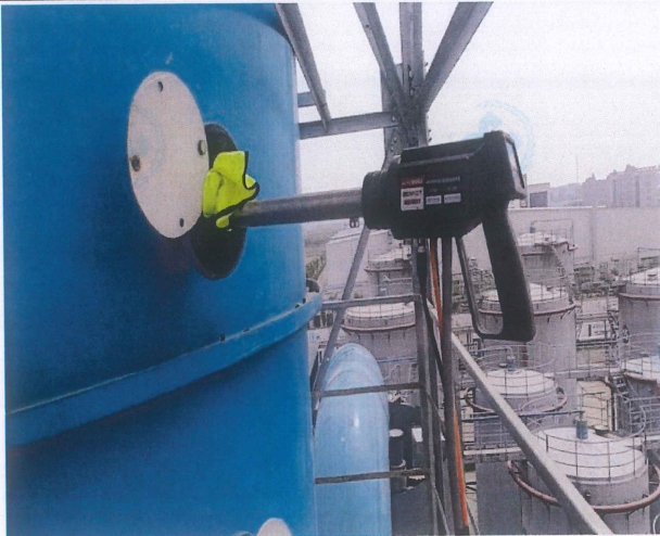
图 3: ●G2 1~3#仓库、料坑、综合处置车间
