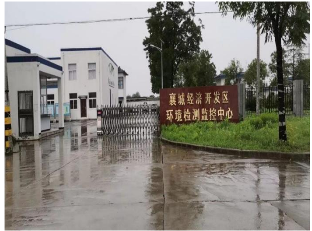
图 4：废水在线监测设备站房
