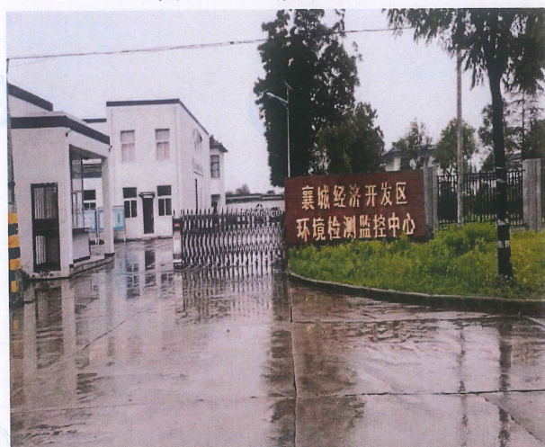
图 4：废水在线监测设备站房
