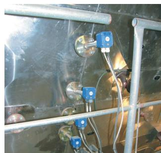
对于存在较强腐蚀性的工艺流程，UWT带全涂层的射频导纳料位开关RFnivo是整个系统一个新的安全解决方案。例如，所有应用烟气净化工艺的地方，除了垃圾焚烧厂之外，这种情况还适用于生物质发电厂、泥炭和煤电厂。测量传感器的增强型防腐蚀保护对于一些特定的烟气净化工艺是一个非常重要的话题，如，化工厂的污泥燃烧以及综合垃圾焚烧厂的焚化炉等为了生产能源的地方。
